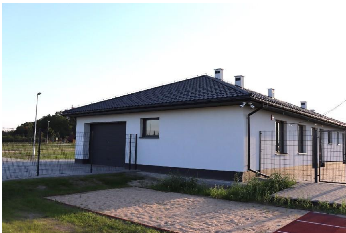
Budynek socjalno-gospodarczy z szatniami
